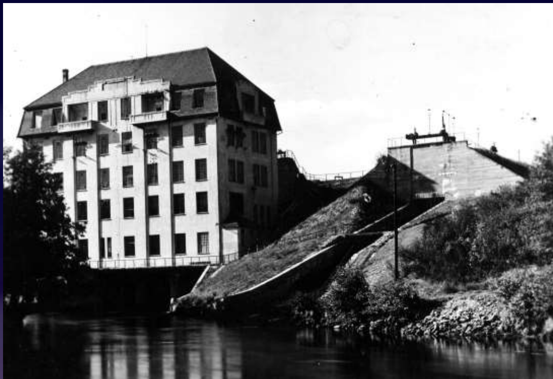
Pierwsza hydroelektrownia w II RP Gródek, 4MW, rzeka Wda
