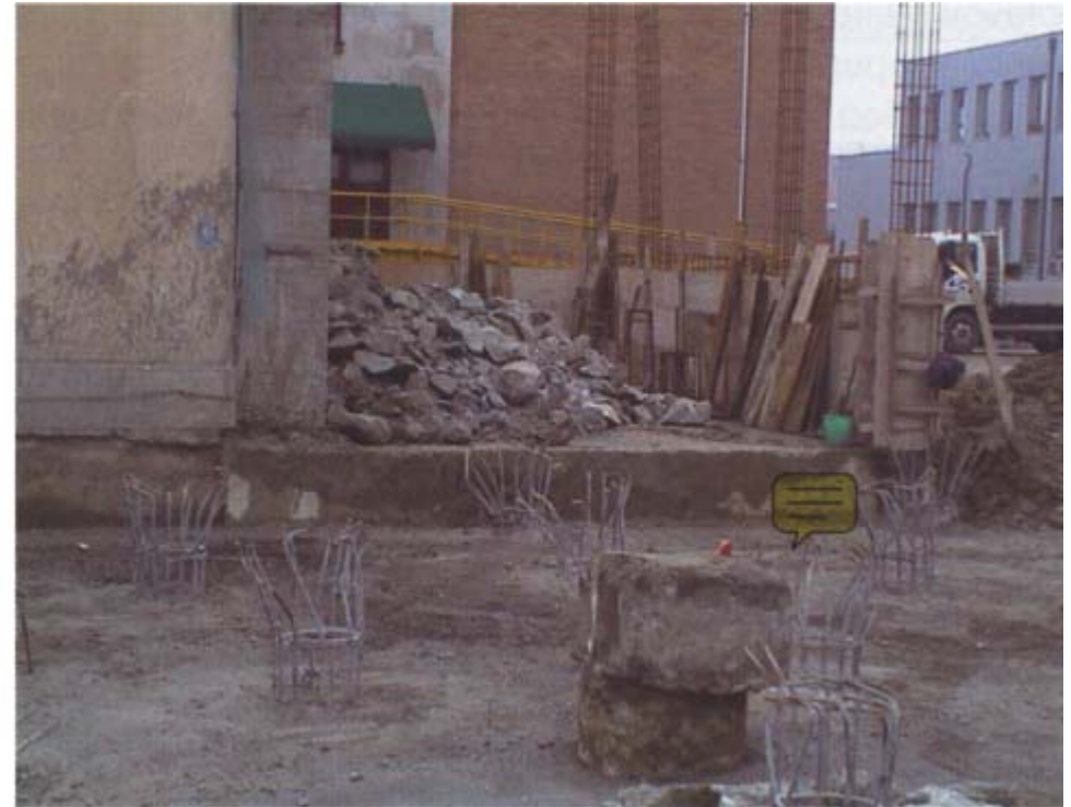
vista delle teste dei pali prima e dopo la scapitozzatura
