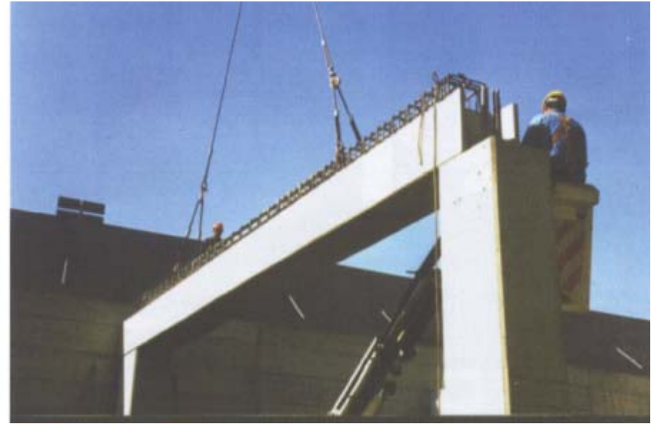
Movimentazione e posizionamento delle travi prefabbricate
