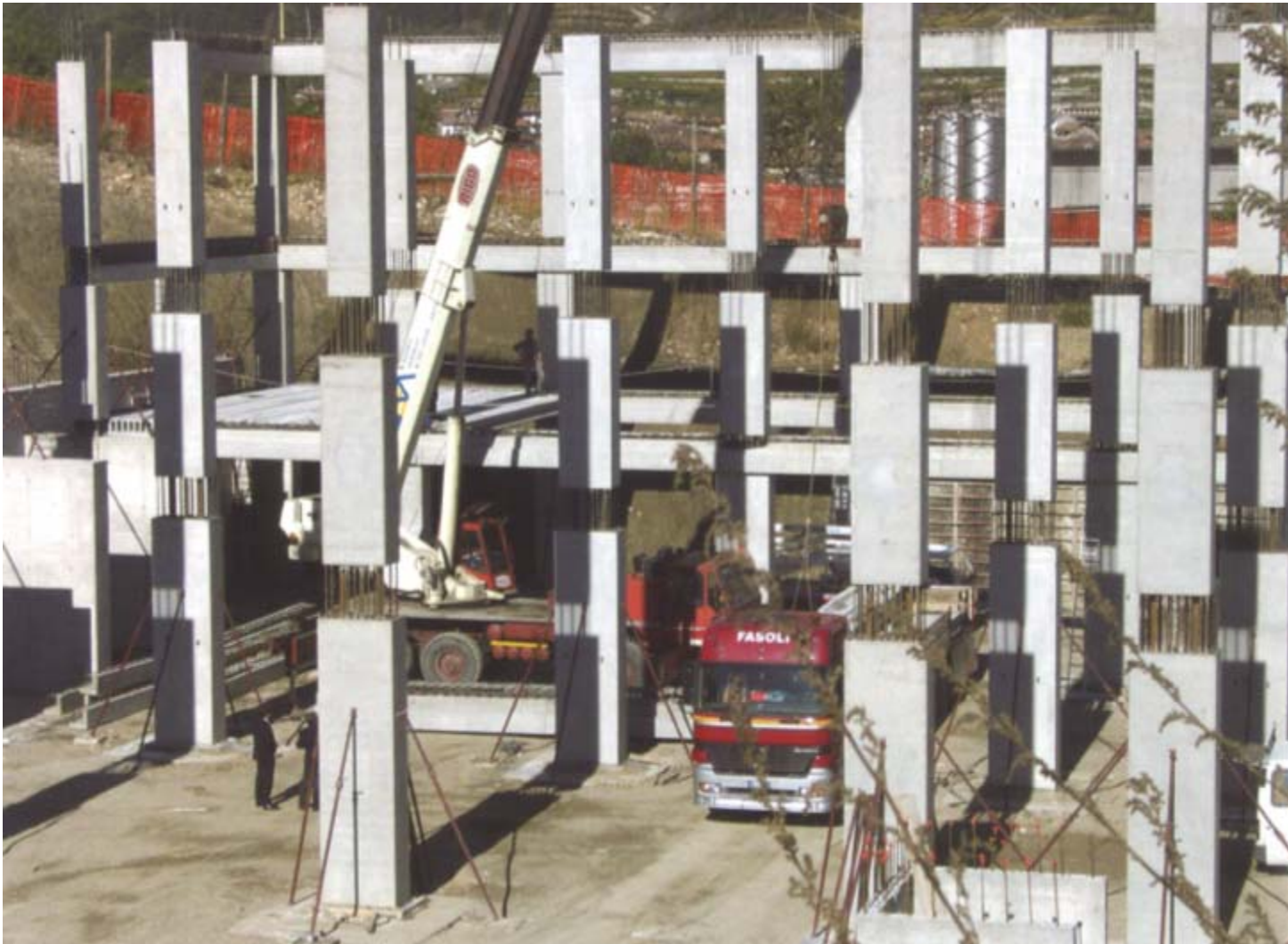
Pilastri pluriplano prefabbricati durante la loro movimentazione e messa a piombo in cantiere
