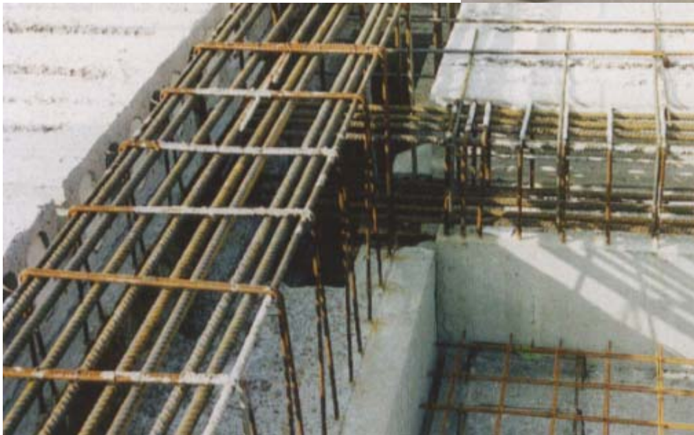
Travi prefabbricate prima e dopo la posa in opera
