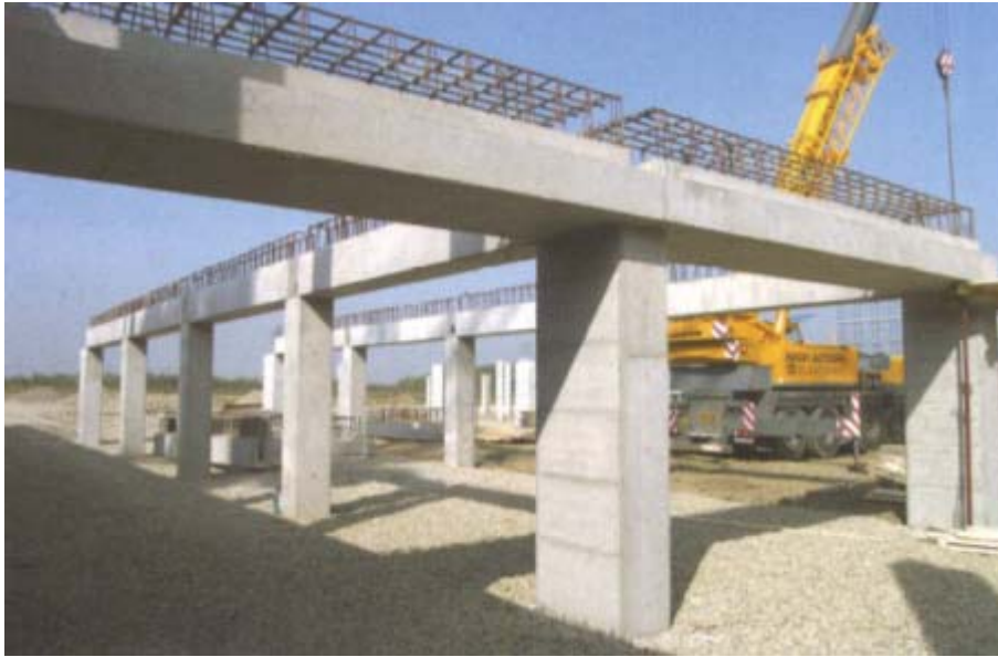
Movimentazione e posizionamento delle travi prefabbricate
