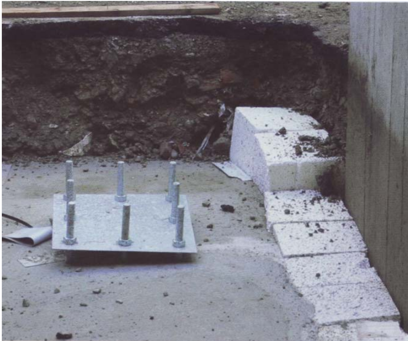
Piastra con tirafondi nel plinto di calcestruzzo dopo il getto
