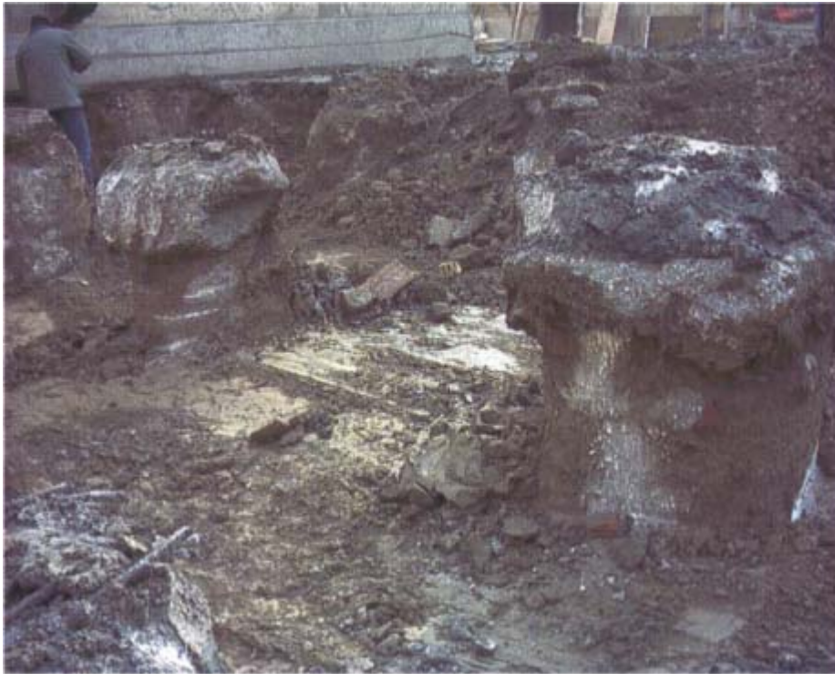
vista delle teste dei pali prima e dopo la scapitozzatura
