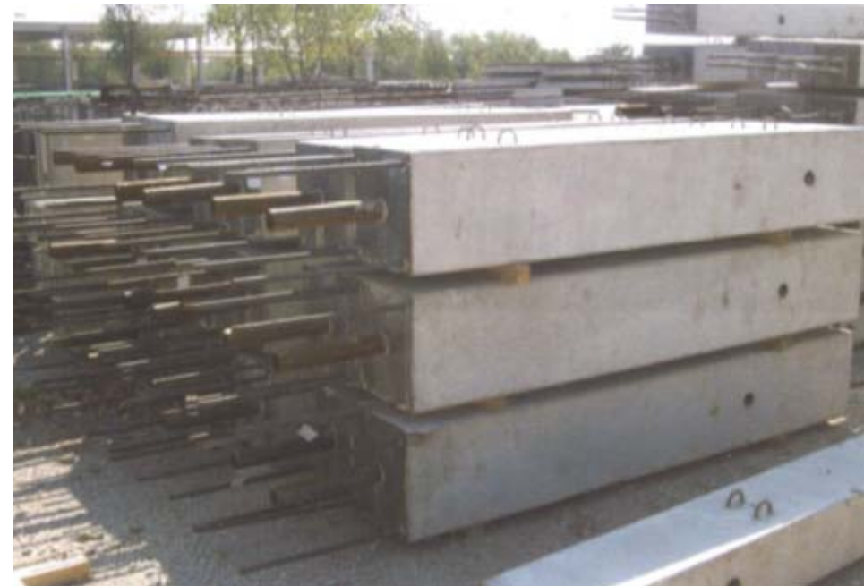
Stoccaggio di pilastri prefabbricati prima del loro montaggio
