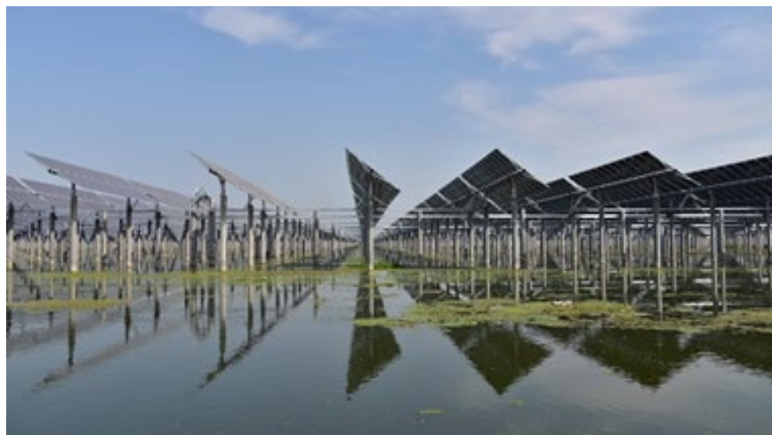
Dwustronne panele słoneczne na wodzie w Chinach
