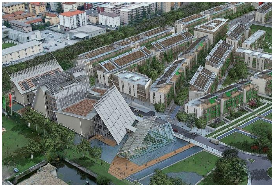
Ryc. 6.46. Futurystyczna architektura nowego (czerwiec 2012) muzeum nauki w Trydencie (budynki z lewej części obrazu); źródło: http://www.trentocultura.it/?lang=it&s=7&mod=news&cId=297&catId=4 (18.10.2012)
